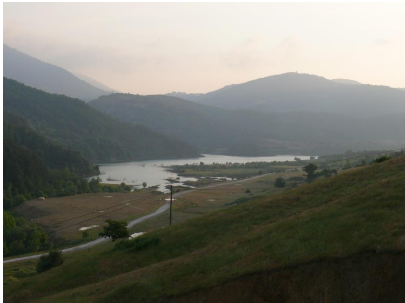
Foto 38: Kestel batısında Nilüfer Çayı vadisi üzerinde su tutma ve inşaat çalışmaları süren Nilüfer Barajına batıya bakış (Ahmet Ertek arşivi, 18.06.2011)
