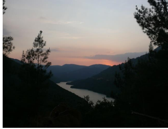
Foto 37: Nilüfer Çayı'nın yarararak açtığı Misiköy Boğazına inşa edilmiş Doğancı Barajı'nda gün batımı (Ahmet Ertek arşivi, 18.06.2011).
