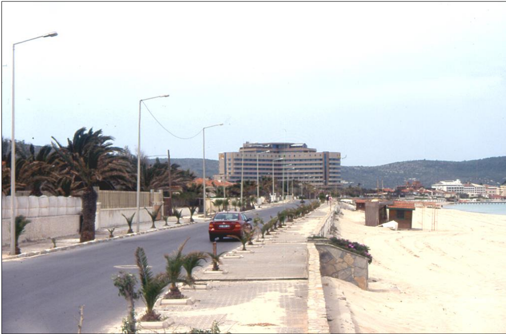
Foto 5: Çeşme Ilıca mahallesinde plaj alanından deflasyonla taşınan kumlardan korunmak için konutların önü duvar ve perdelerle kapatılmıştır.
