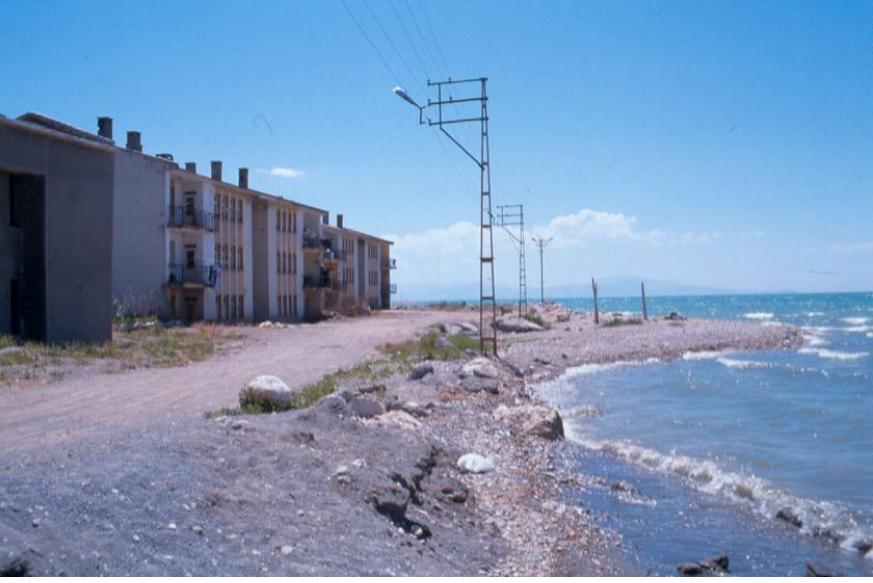
Fotoğraf 14. Son yıllarda Van Gölünün yükselen suları altında kalan binalar. Binaların birinci katına kadar dolgu çalışması yapılmıştır.
