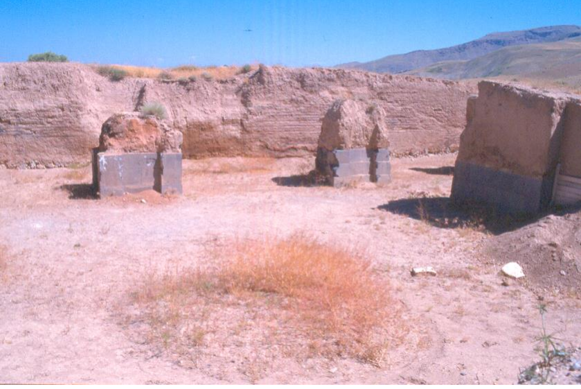
Fotoğraf 20. Ayanis kalesindeki Payeli salonun taş örgü sütunlarının eğrilmiş olması ve taşların çarpılması, yörenin deprem etkisine uğradığının işaretleridir.
