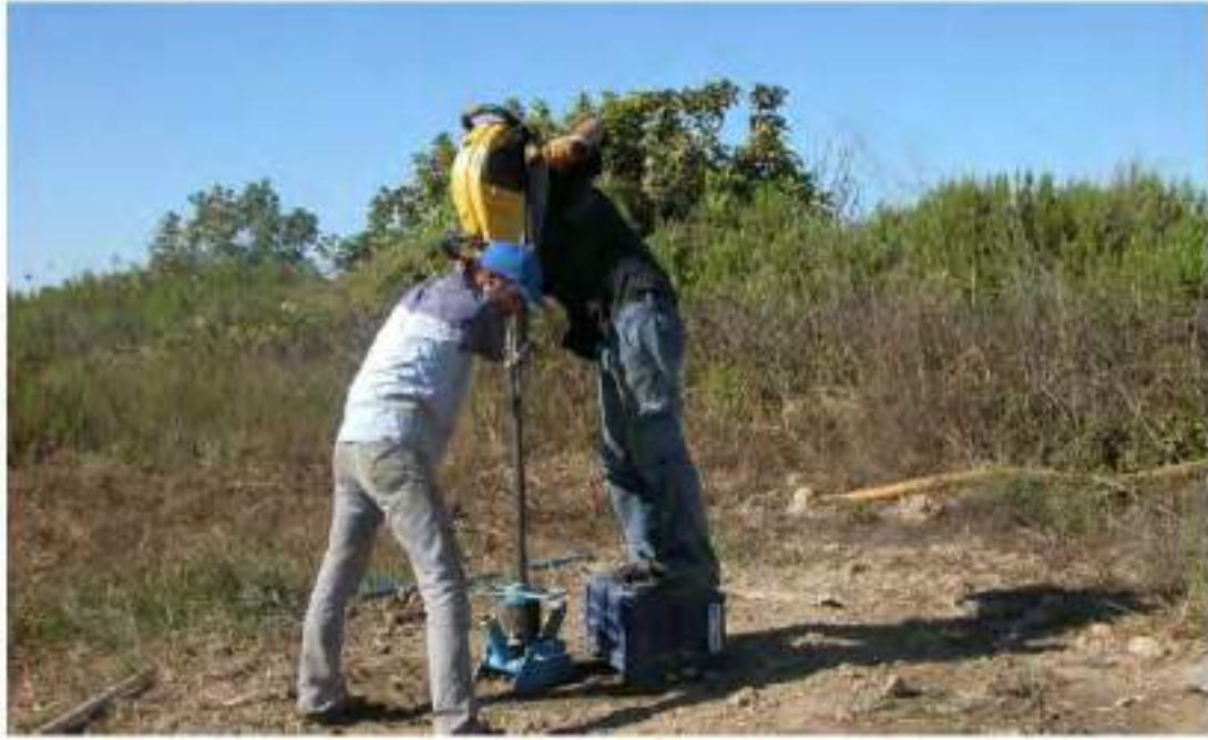
Foto 2. Sondaj çalışmaları Cobra Mk1 ile yapılmıştır.
