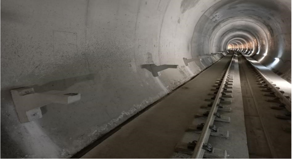
Görsel 37: Fahrettin Altay - Narlıdere Hattı Tünel İçi Ray Döşeme Çalışmaları 243
