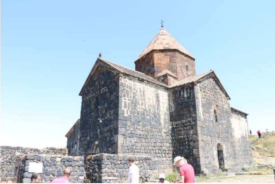
Resim 6: Surp Asdvadzazin Kilisesi güneybatıdan görünüş (G. Sağır arşivi, 2019)
